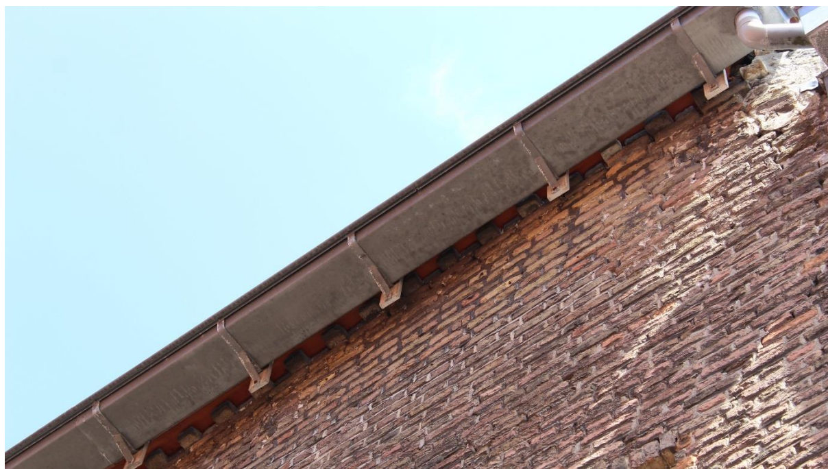
Figuur 25: Het restant van de bloktandlijst onder de goot.
