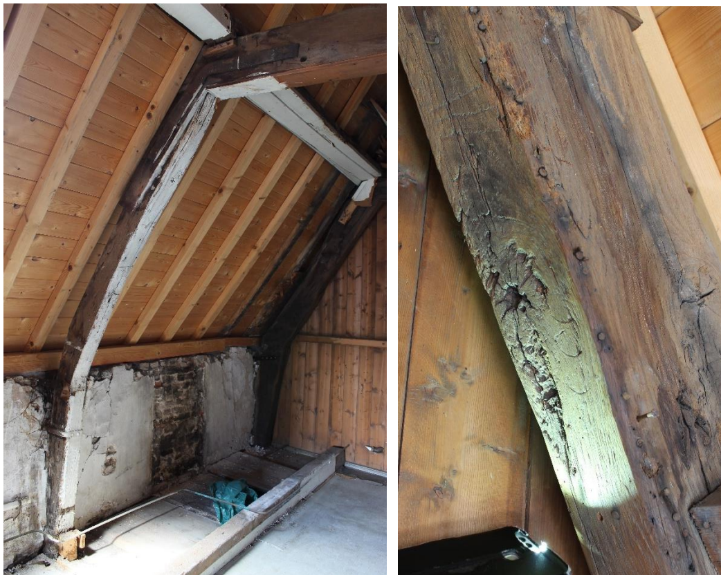
Figuur 30: Eén van de spantbenen en het gehakte merk 3.
