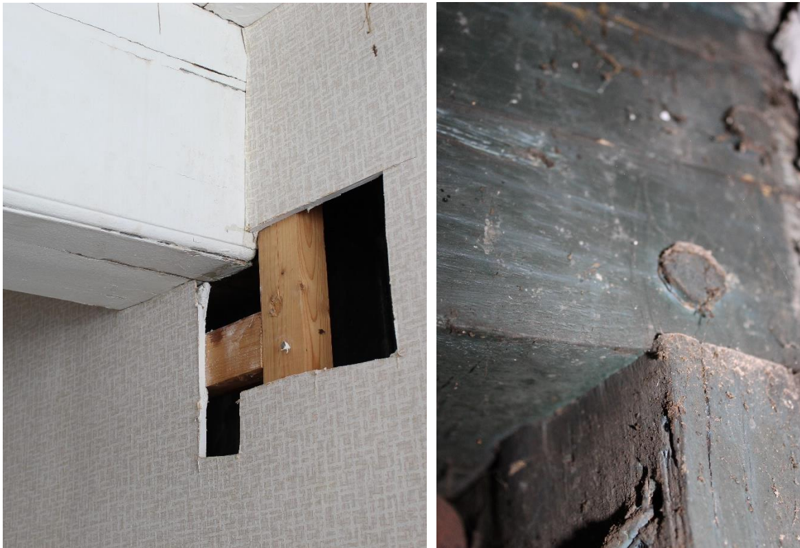
Figuur 29: Kijkgat in de gipsen voorzetwand. Rechts de muurstijl en moerbalk die achter de wand aanwezig zijn.
