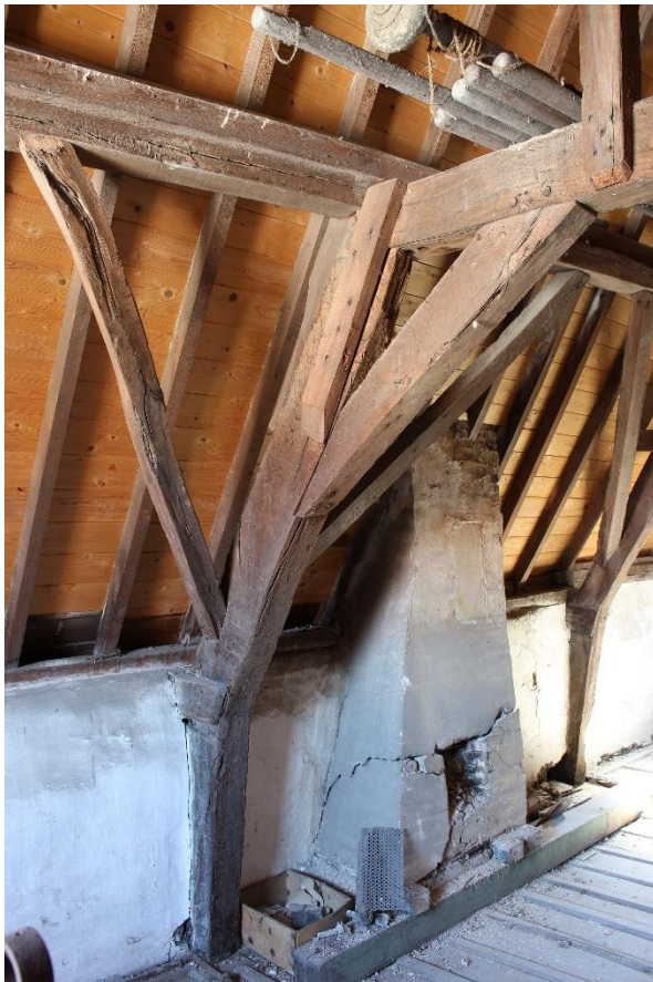
Figuur 22: Eén van de spantbenen. Rechts: gehaald telmerk 2
